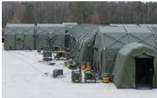
Feldlazarett und kombinierte ABC-Klimaanlage für Container
